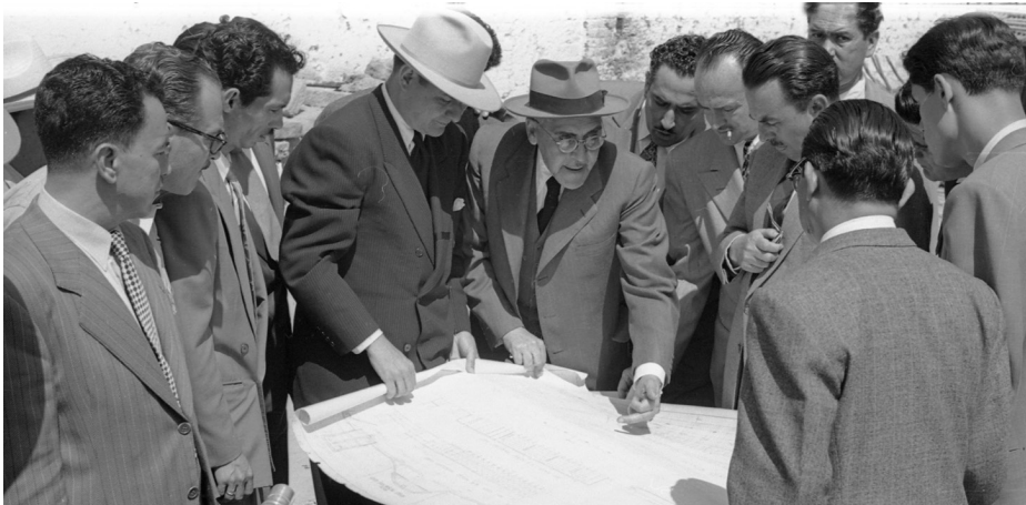
Supervisando personalmente las obras. El ingeniero Eduardo Molina explica a Uruchurtu los pormenores de las obras del drenaje, 11 de marzo de 1953. © Secretaría de Cultura del Gobierno de la Ciudad de México. Reproducción autorizada por el Museo Archivo de la Fotografía.
