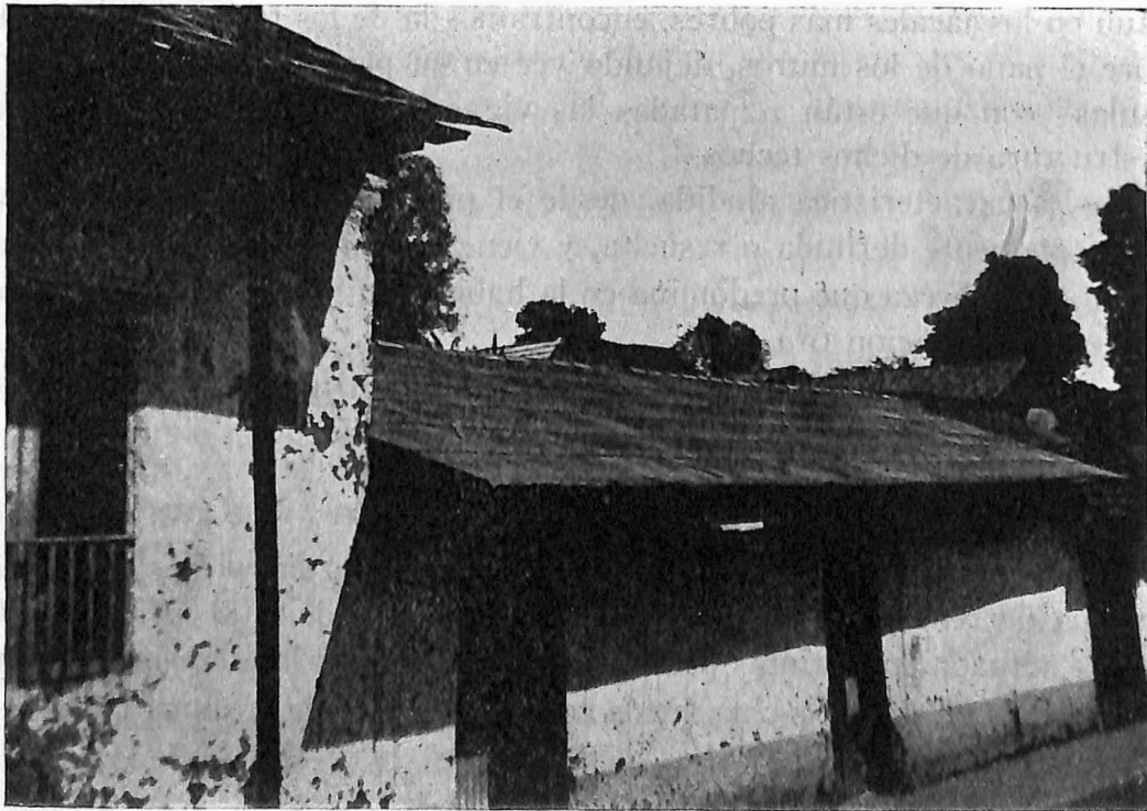
Casa de muros de adobe y techos de tejamanil. Erongarícuaro, Mich.
