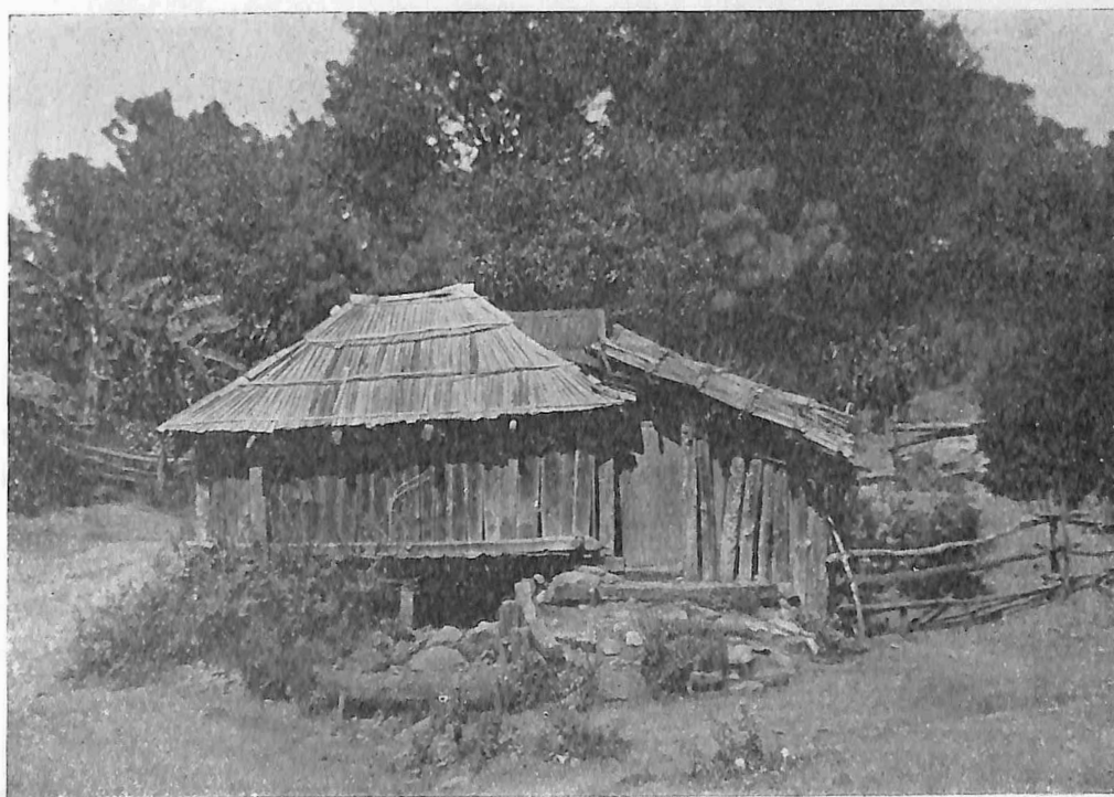
Casa de paredes de vigas de madera y techos de tejamanil o teja. Zacapu, Mich.
